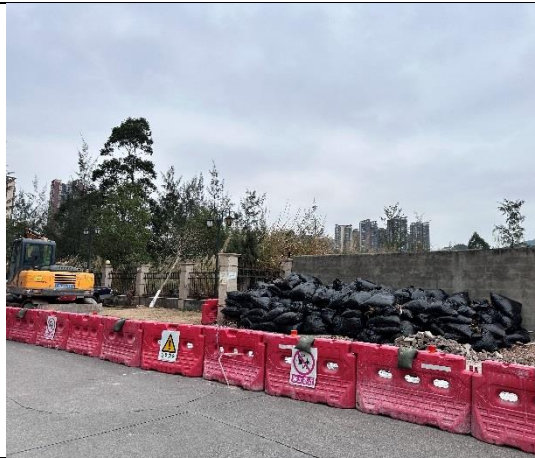
本项目终点龙山十路交叉口现状
