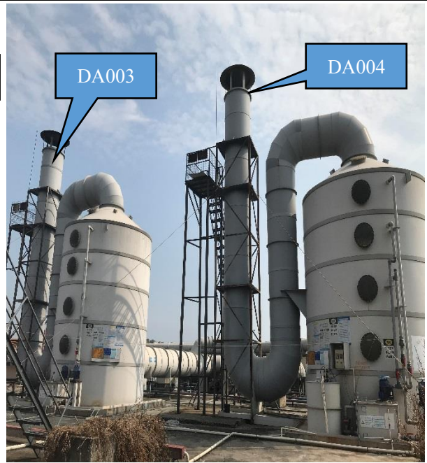
改造后的四套废气酸碱废气处理设施
