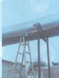
G10 隧道炉、洗网房、文成印刷废气处理前检测口
