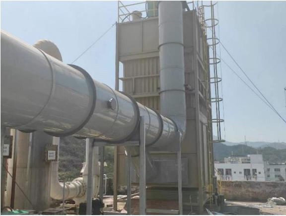
TA045碱性喷淋+微波射频酸雾净化装置
