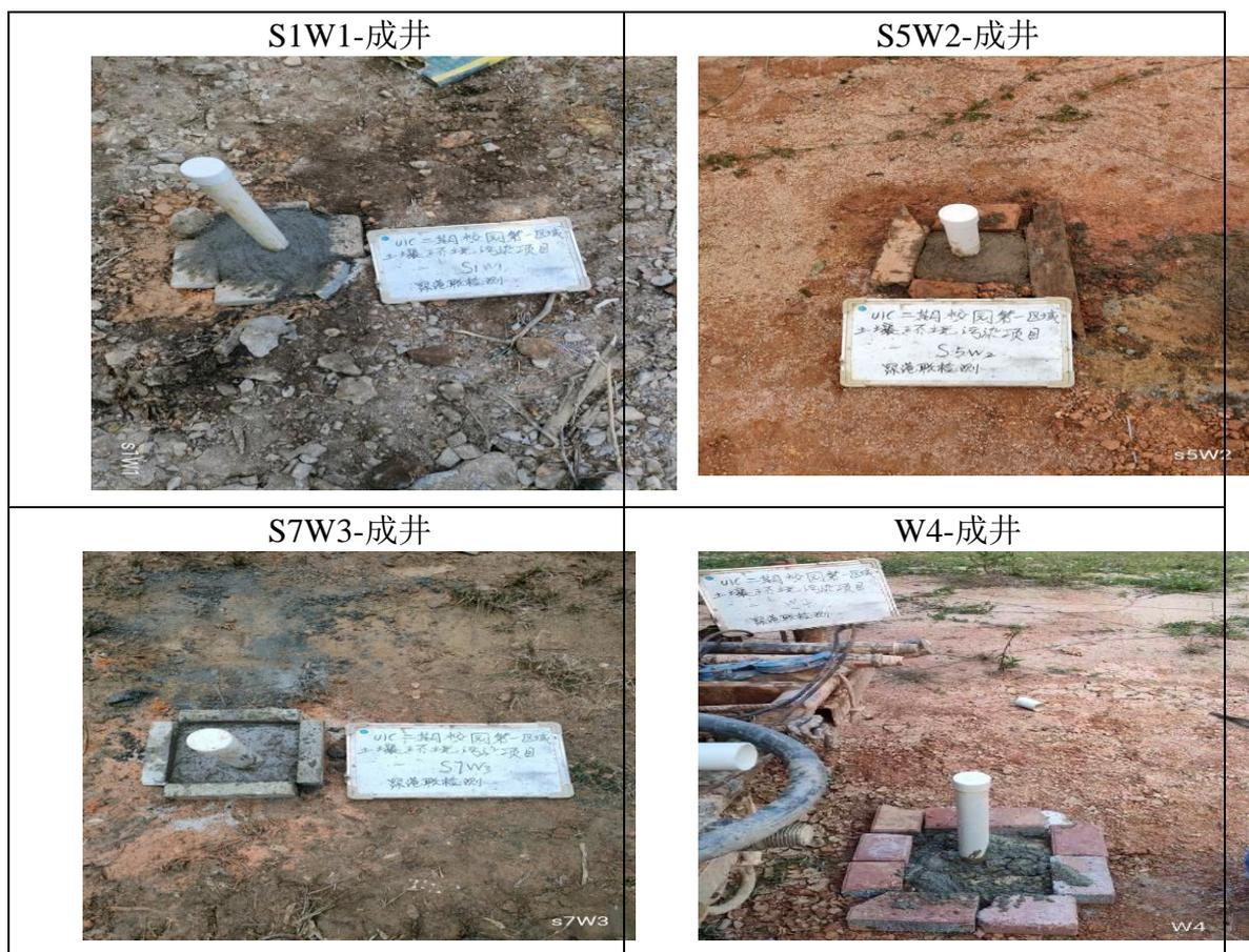
图 4.2-4 地下水检测井成井图
